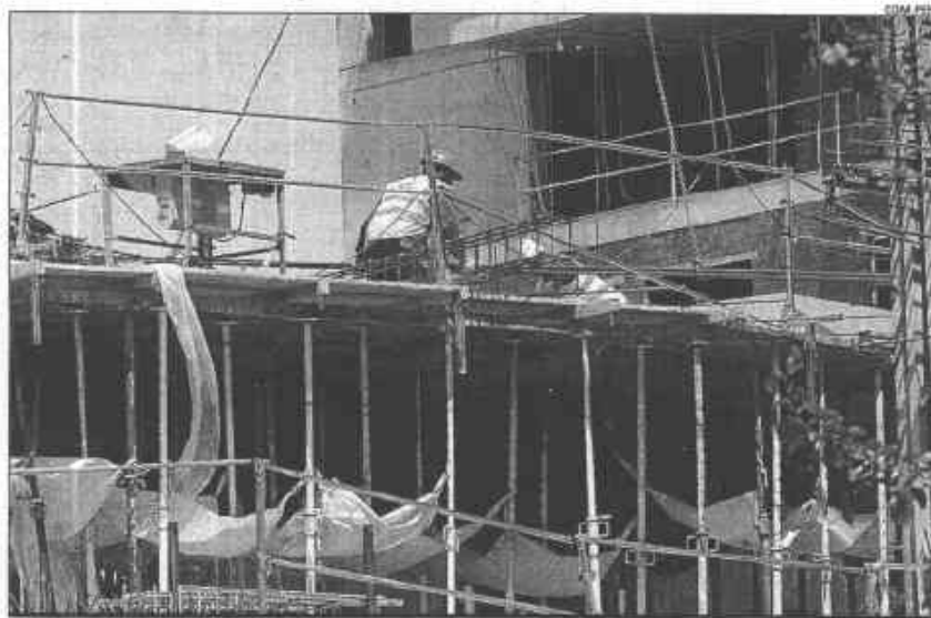
Imagen de un edificio en obras en Murcia
